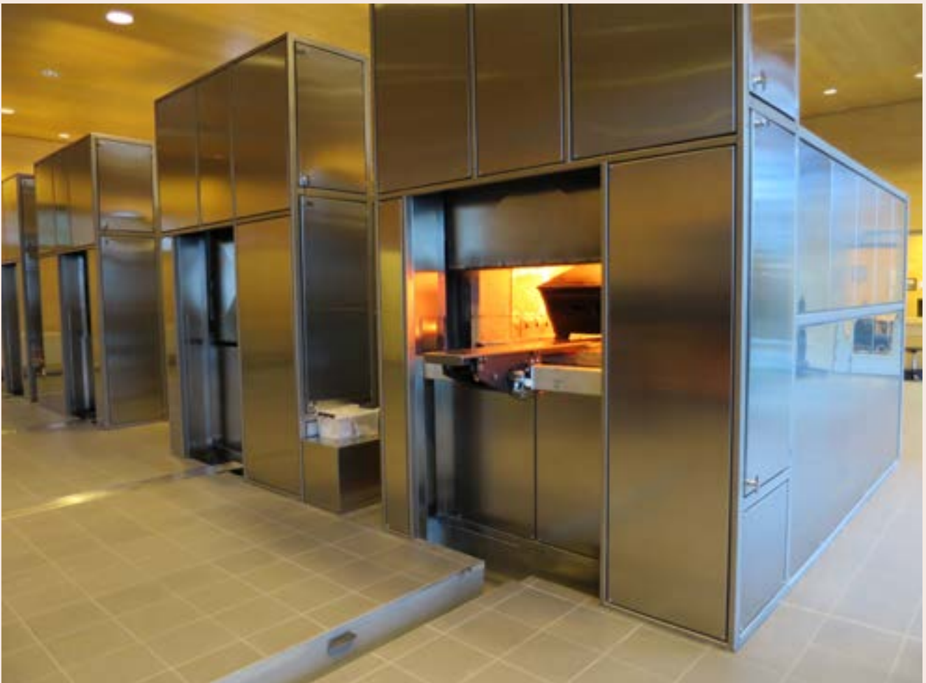
Ovner ved Alfaset krematorium. Foto: SHS.
